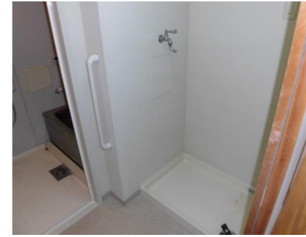
洗濯機置き場
