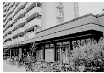
八尾市立志紀図書館(住宅敷地内)
