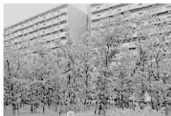
ふれあいの森 (住宅敷地内)
