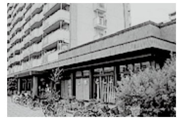
八尾市立志紀図書館 (住宅敷地内)
