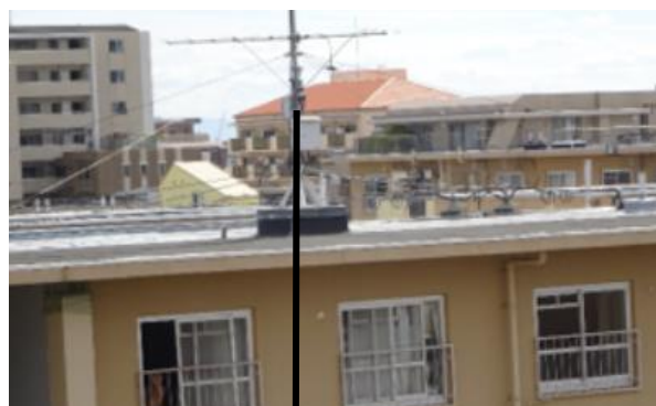
⑥テレビ共同受信アンテナ (府で設置したもの)
