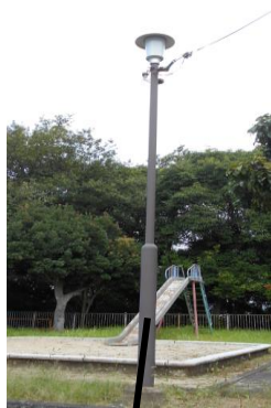
②外灯ポール取替 (腐食等危険性のあるもの)
