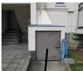
⑤ダストシュート修繕
