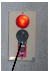
②非常警報ベル及び押ボタン
